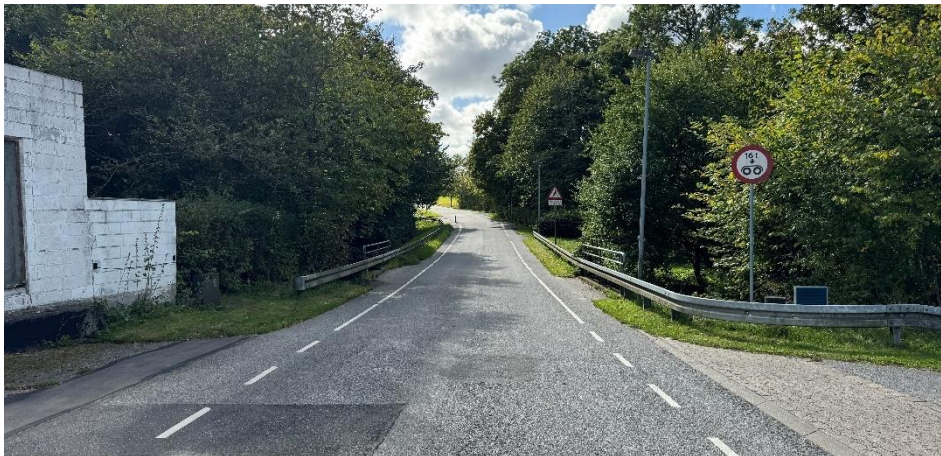
Figur 13: Bygværk på Ravnshøjvej i Kvissel.
