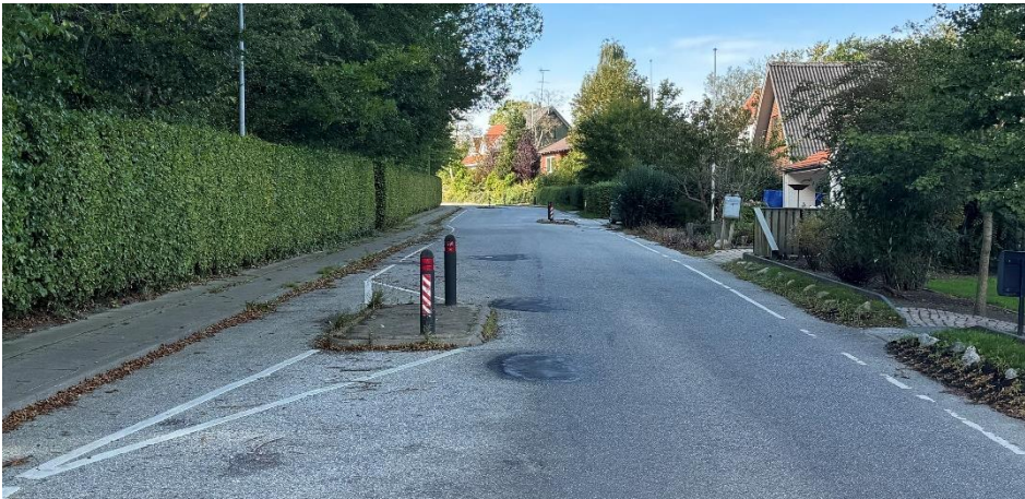
Figur 15: Mejlingvej i Kvissel med indsnævring til ét spor.
