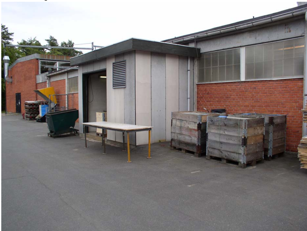
Foto 7: Bygning 11 (vestside), udendørs oplag af maling, fortynder, granathylstre mm.
