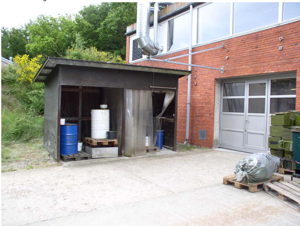
Foto 9: Bygning 11a, oplagsskur med malerester.
