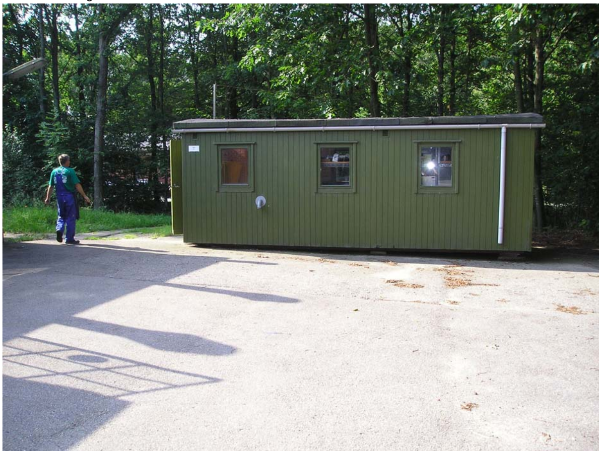
Foto 23: Skurvogn ved bygning 32, hvor der affedtes større metalemner i et lukket affedningsanlæg
