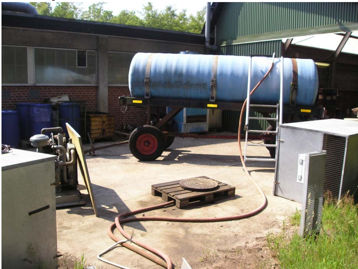
Foto 15: Bygning 14, oppumpning af spildevand (bejdseprocessen) fra opsamlingsbrønd til tankvogn. Opsamlingsbrønden er af og til løbet over.
