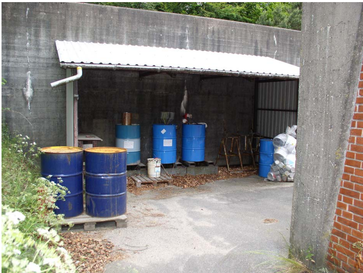
Foto 32: Bygning 5a, oplagsskur ved bygning 5 med malerester og opløsningsmidler.
