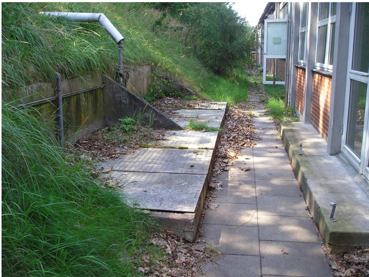
Foto 42: Bygning 6, bundfældningsbassin for spildevand fra bygning 6 og 16.
