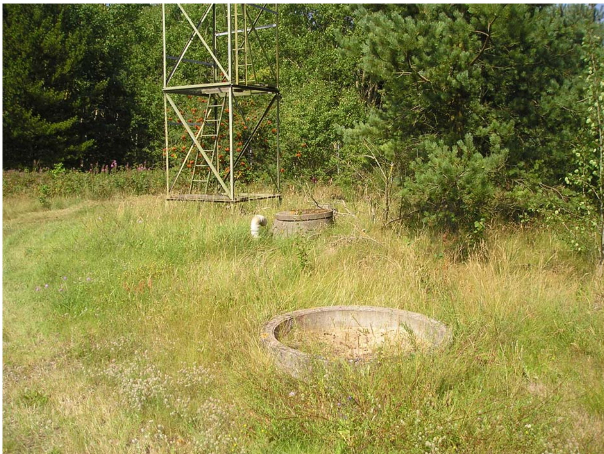
Foto 36: Depot 69a, olieudskiller ved depotet med olieforurennet jord.
