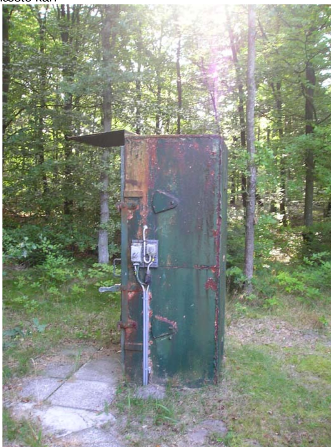
Foto 20: Satsblandeskur ved bygning 27.
