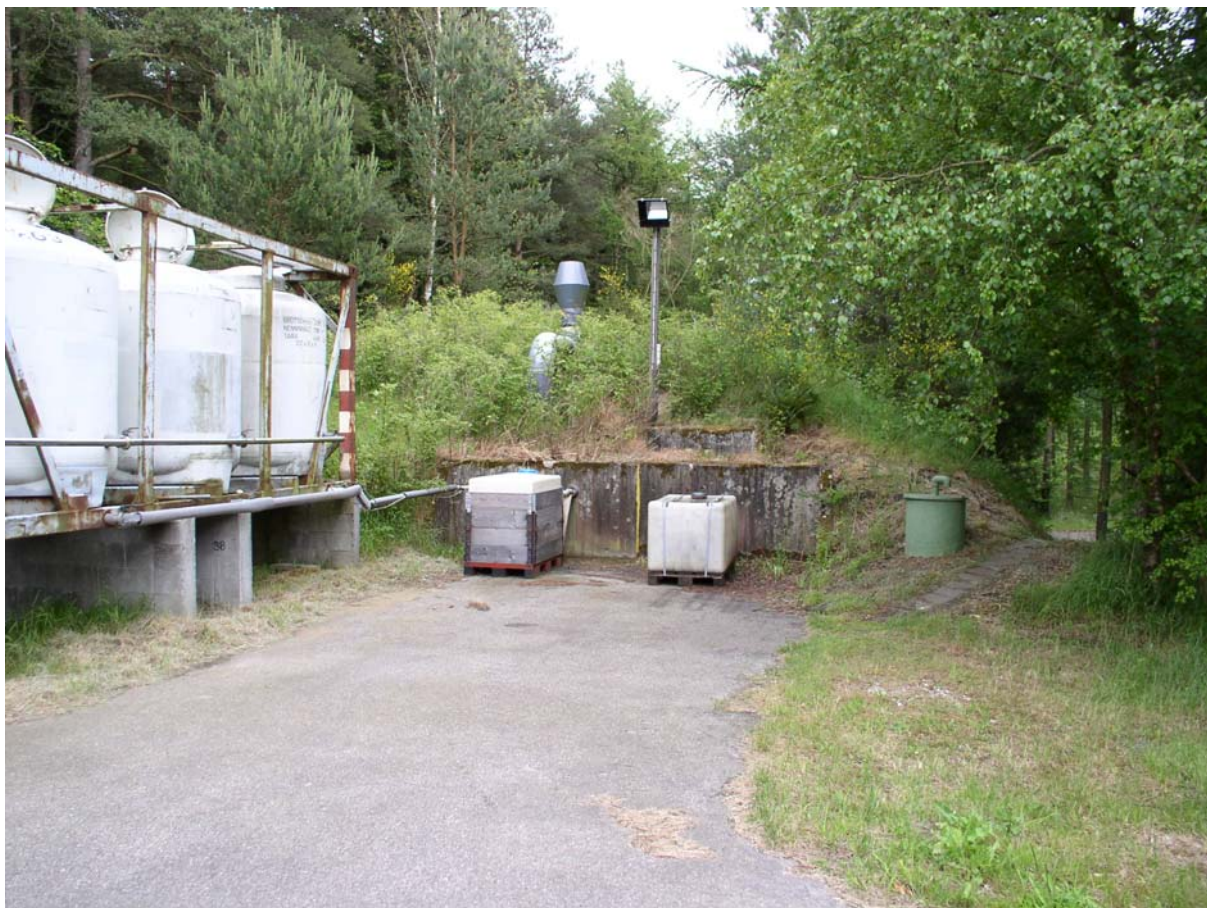
Foto 40: Bygning 69, spildevandstanke ved forrenseanlæg. Den grønne tank til højre har været brugt til natrumhydroxid.
