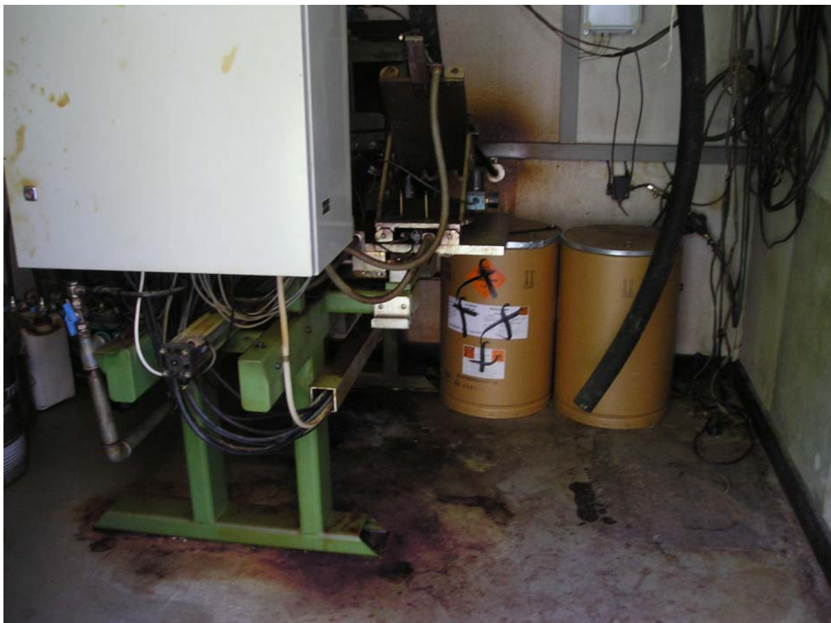
Foto 6: Bygning 8, rum til udboring af trotyl fra granater.
