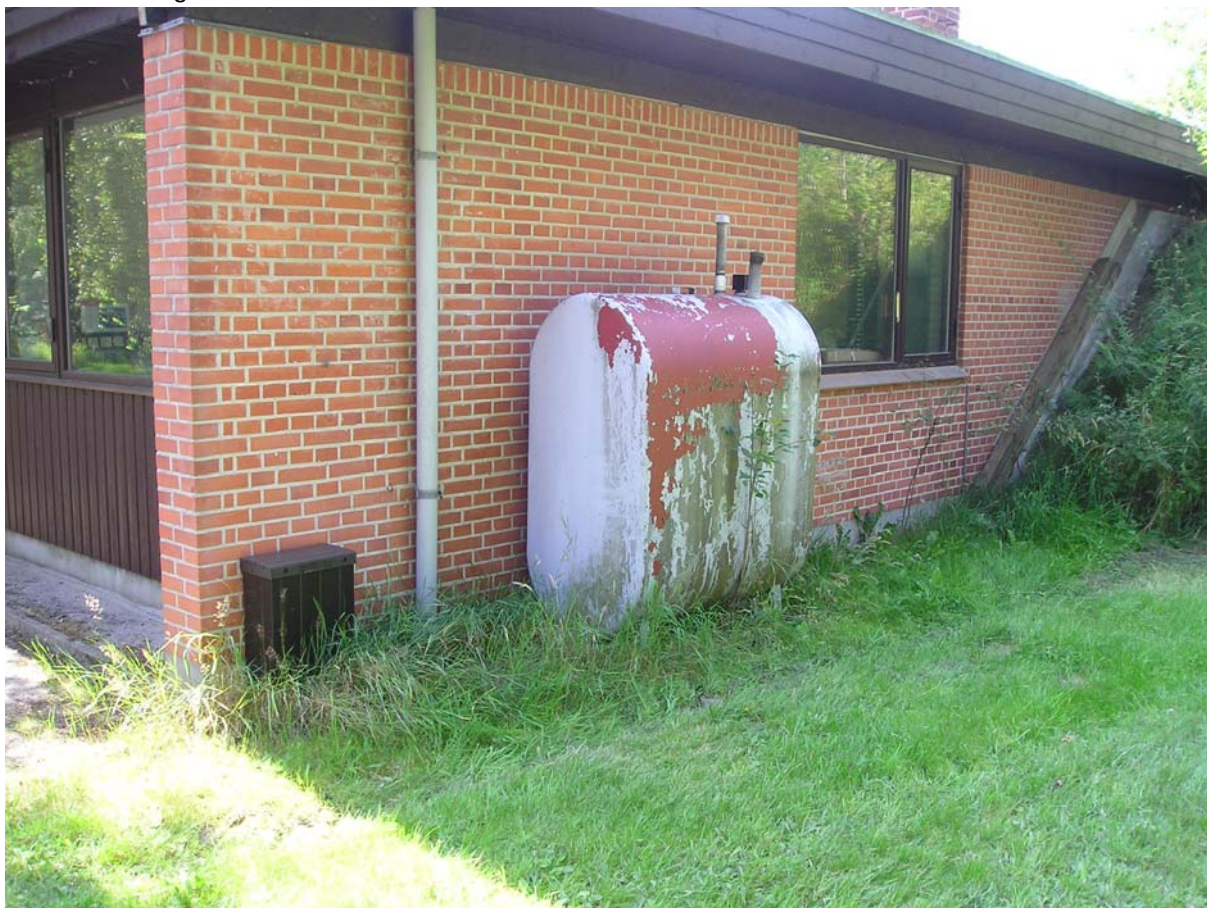
Foto 1: Bygning 61, overjordisk olietank.
