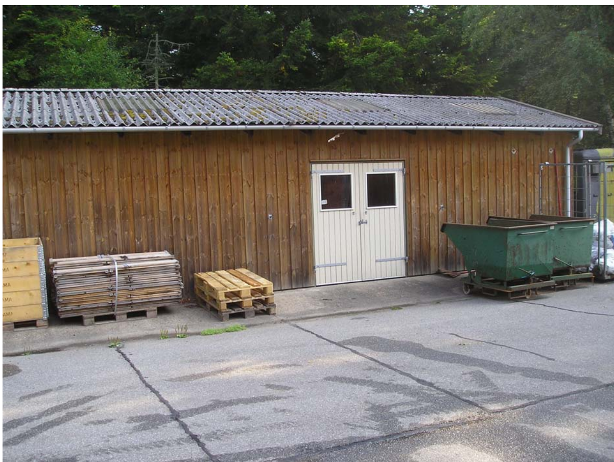
Foto 30: Bygning 20a (Syreskuret), tidligere oplagskur for kemikalier.
