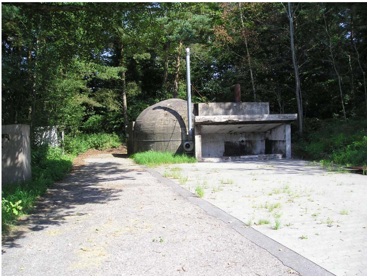
Foto 38: Bygning 57, sprænggrotte med foranliggende betonkasse til test af kanonslag.
