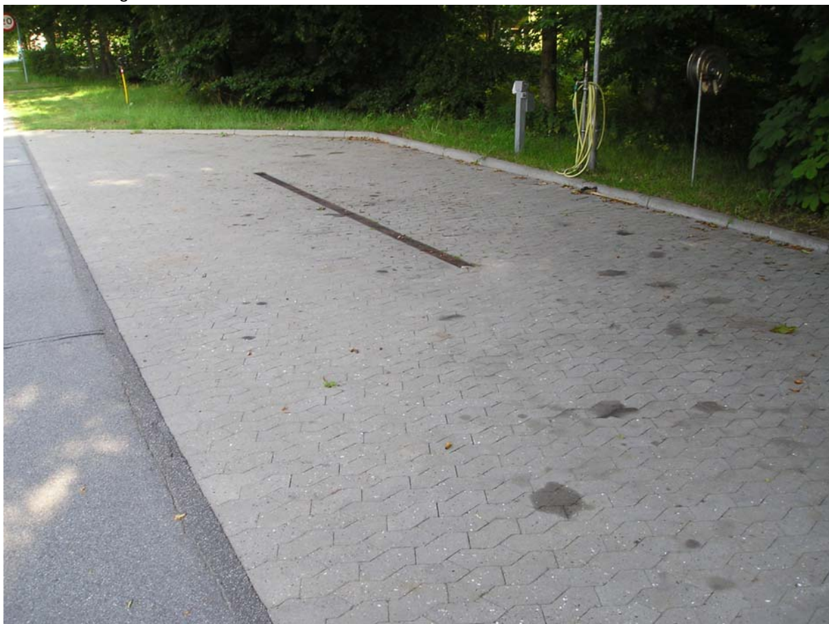
Foto 39: Vaskeplads med olieudskiller nord for bygning 31.
