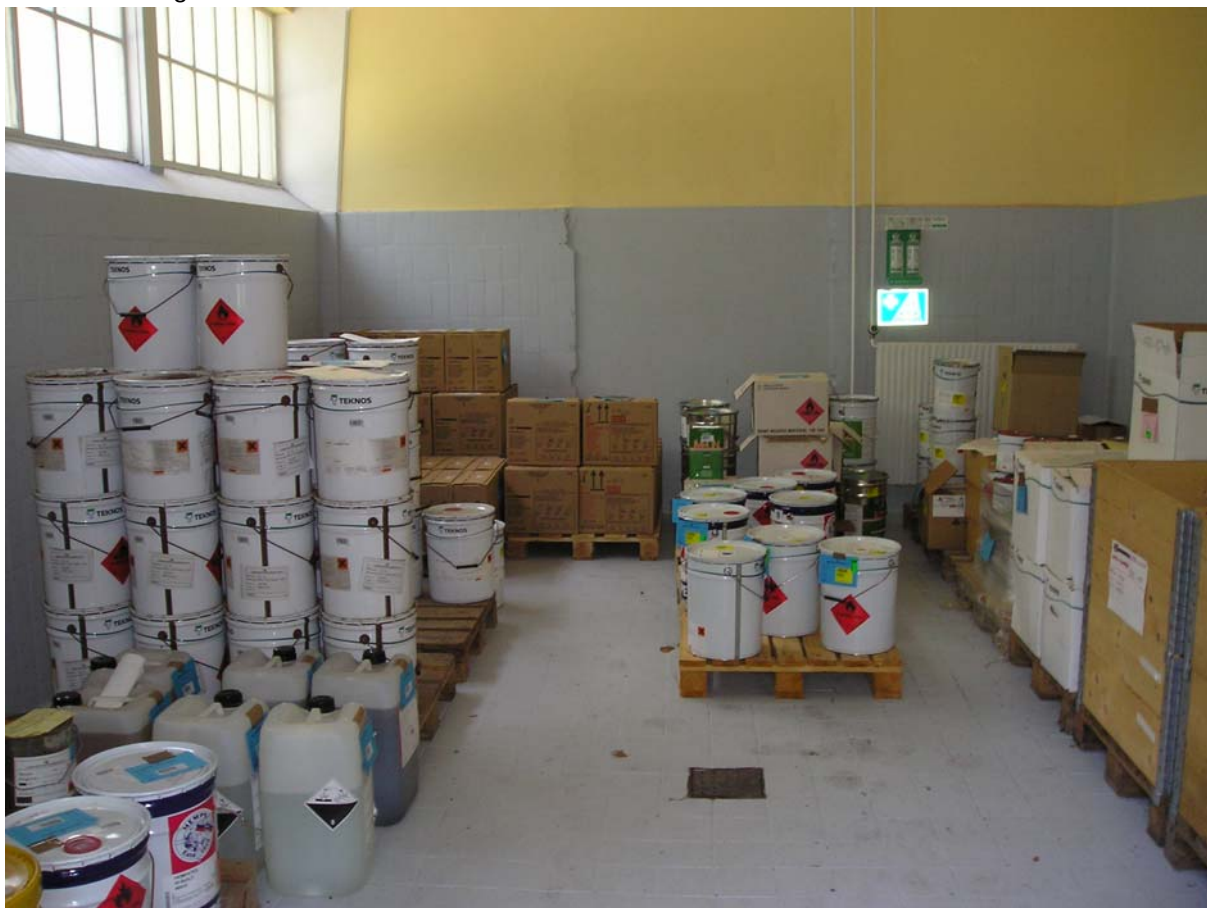
Foto 31: Bygning 31, oplag af maling, lak og fortynder. Afløbet i gulvet er formentlig fyldt op med sand.
