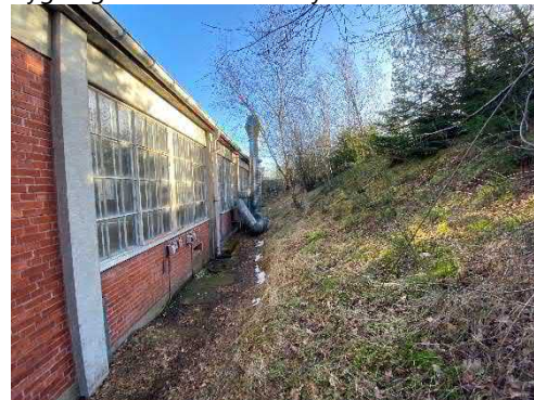
Foto 4: Sydlige facade med udsug – ud mod jordvold. Foto set mod øst.
