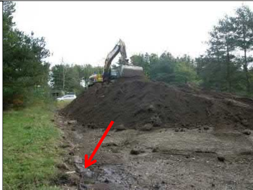
Foto 3: Opgravning af olieforurenet jord – plastikmembran ses i kanten af udgravning.
