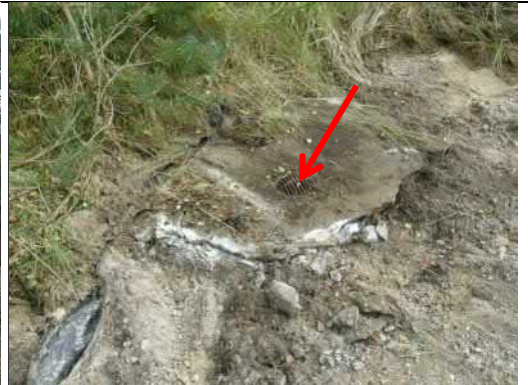
Foto 4: Afløbsrist i depotets nordlige afgrænsning.
