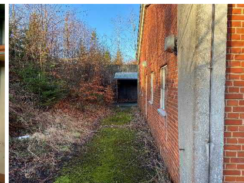
Foto 9: Skur med oplag af malingsrester v. det sydvestlige bygningshjørne (samme område som foto 6, fra modsatte retning).
