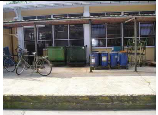
Foto 4: Bygning 32 (nordside), udendørs oplag af olieholdige metalspåner.
