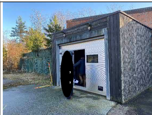
Foto 3: Bygningens vestlige gavl med indgangsslusen.
