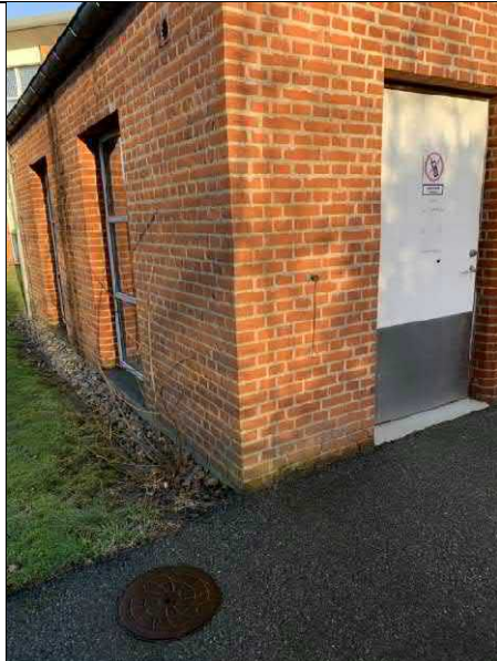
Foto 2: Bygning 12 set mod vest.
