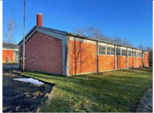
Foto 3: Sydlige facade og vestlige gavl, hvor dieselolietank (kilde 10126-0002) tidligere var opstillet.
