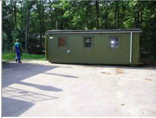
Foto 1: Skurvogn ved bygning 32. Her blev der foretaget affedtning af større metalemner i et lukket anlæg.
