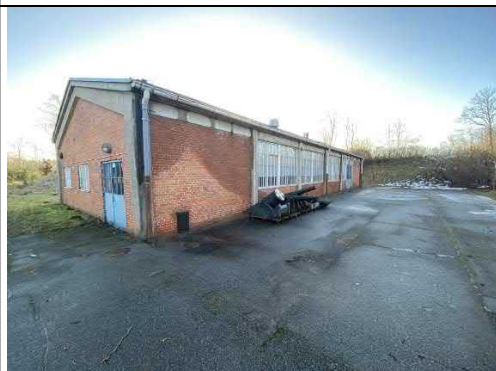
Foto 1: Bygningens facade nordvest.
