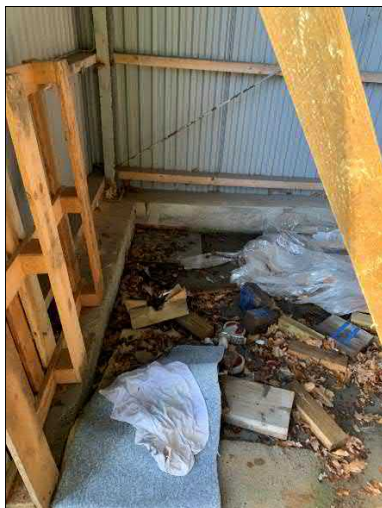
Foto 7: Pumpegrube i det sydvestlige hjørne.
