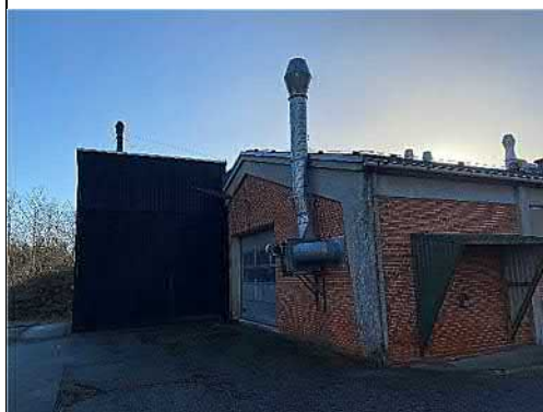
Foto 4: Nordlig gavl med udsug samt tilbygning med slyngrenser.
