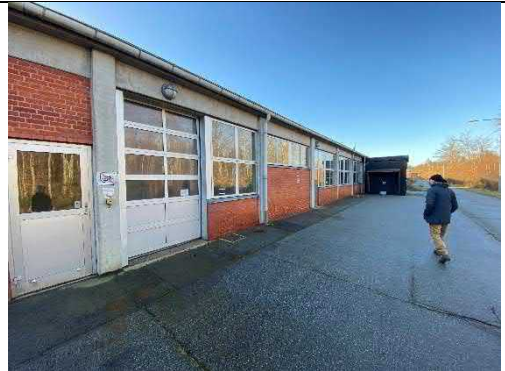
Foto 2: Nordlig facade – ud mod Støberivej. Foto set mod vest.
