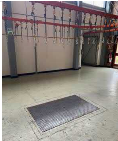
Foto 7: Foto fra det store værkstedsrum i bygningen. Metalpladen er en lift.
