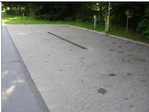
Foto 2: Vaskeplads der formentlig er tilsluttet olieudskiller nord for bygning 31.
