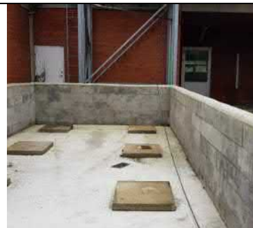
Foto 8: Slamtank er fjernet fra tankgård, som er tom og rengjort. Der er boret hul i tankgård, så der ikke ophobes regnvand.
