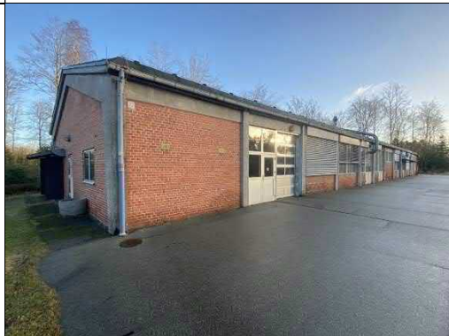
Foto 3: Bygningens sydlige facade.
