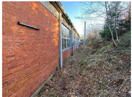
Foto 4: Sydlig facade – ud mod jordvold og med udsug der kan anes centralt i foto. Foto set mod øst.
