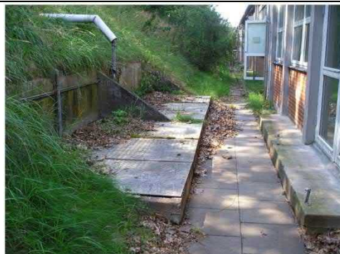
Foto 1: Bundfædningsbassin (6a) syd for bygning 6. Foto set mod vest (2004).
