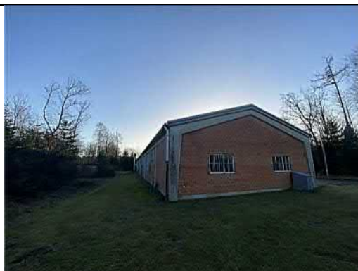
Foto 2: Bygningens vestlige ende og nordlige facade, foto taget mod øst.
