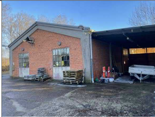
Foto 3: Bygningens vestlige gavl. Rum 107 og rum 108 er placeret i denne del af bygningen.
