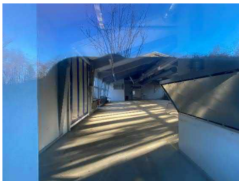
Foto 5: Kig ind gennem vindue til bygning 9 (ingen besigtigelse indenfor). Foto set mod øst.
