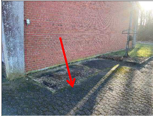
Foto 4: Vestlige gavl, hvor den overjordiske Dieselolietank (kilde 10126-0002) var opstillet (markeret med rød pil).
