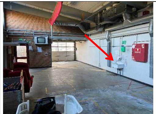
Foto 5: Rum 123 (demonteringsværksted) - der ses en udslagsvask på væggen.
