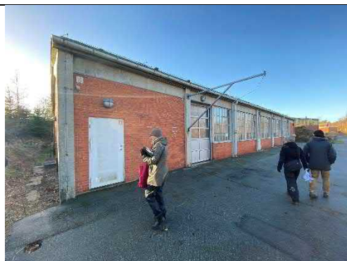
Foto 1: Nordlig facade – ud mod Støberivej. Foto set mod sydvest.
