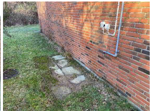
Foto 4: Område ved den sydlige langside, hvor der evt. har været placeret en tank.
