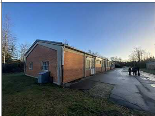
Foto 1: Bygningens sydlige facade, foto taget mod øst.
