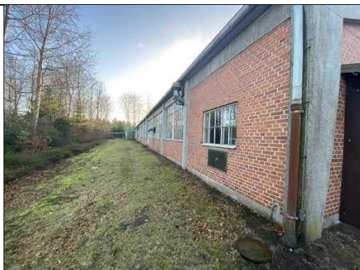
Foto 5: Bygningens nordlige facade.
