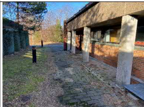
Foto 2: Bygningens sydlige facade.
