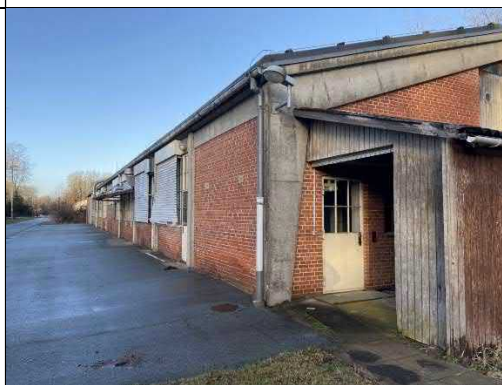
Foto 10: Bygningens sydlige facade.
