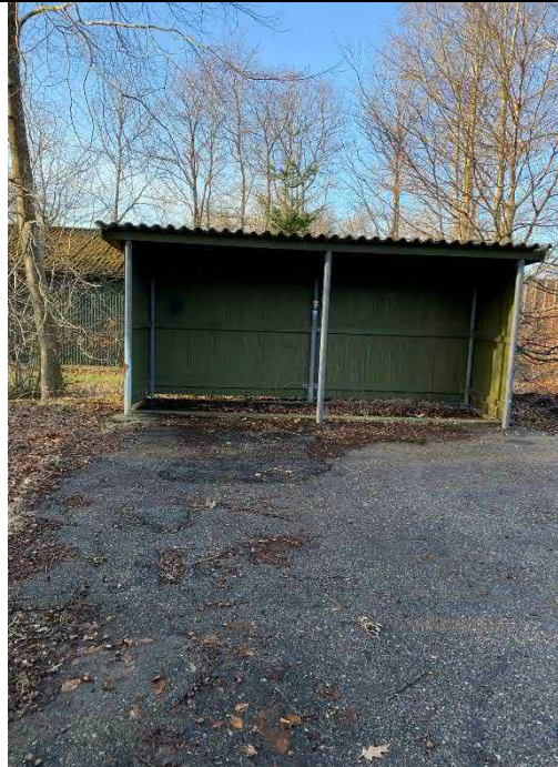
Foto 3: Skuret ved bygning 32.
