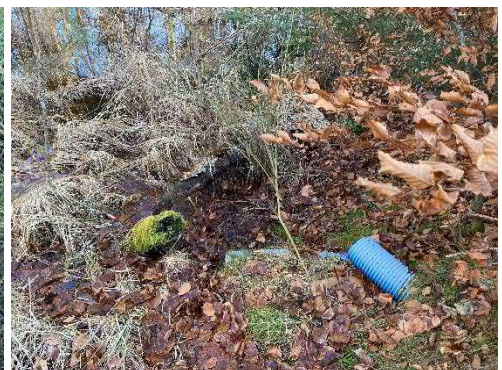
Foto 6: Udledning af drænvand/tagvand til vådområde nord for bygning 7.
