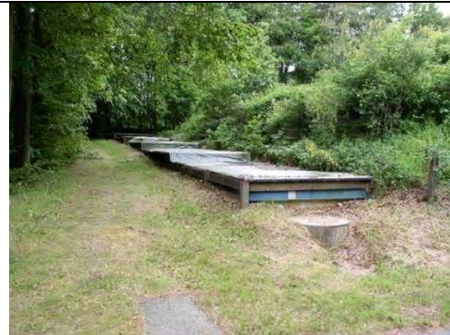
Foto 2: Laksetrappe til rensning af spildevand (6e-6i) fra bygning 6 og 16. Foto set mod syd (2004).
