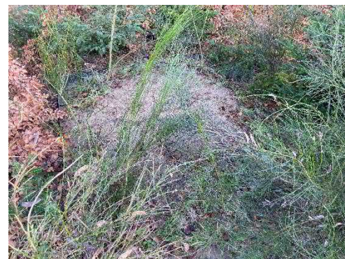
Foto 5: Sandfyldt betonkar for den tidligere 4.000 l opsamlingsstank.
