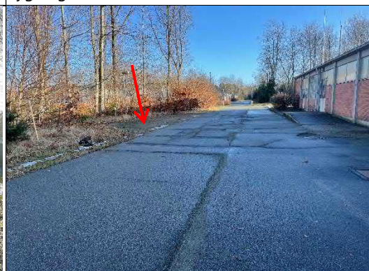
Foto 8: Vaskeplads med olieudskiller nord for bygning 31.
