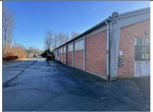
Foto 4: Bygningens nordlige facade.
