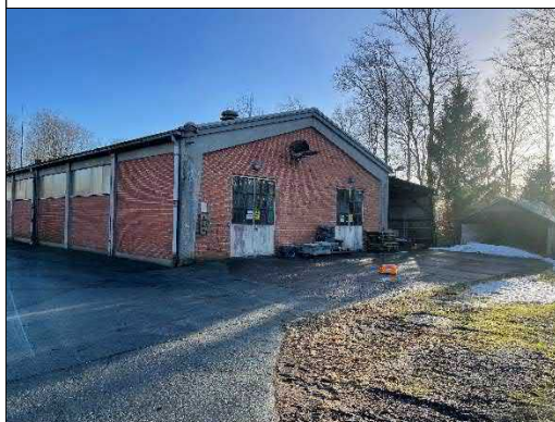
Foto 7: Nordvestlige hjørne af bygning 31.
