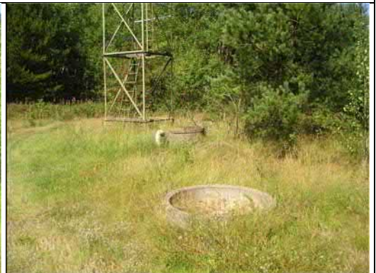
Foto 2: Depot 69a, olieudskiller ved depotet med olieforurennet jord.
