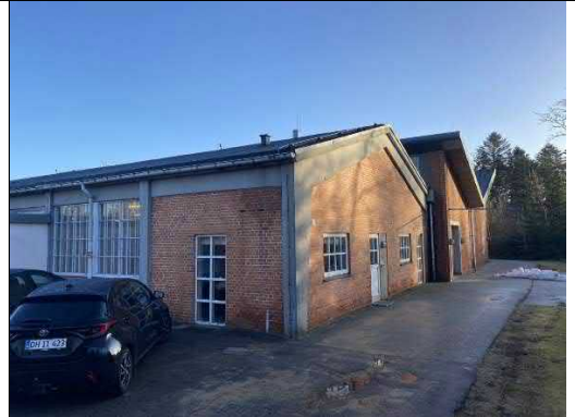
Foto 4: Bygningens sydlige gavl.
