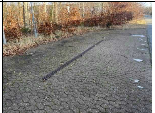
Foto 6: Vaskeplads med afløbsrende nord for bygning 31.
