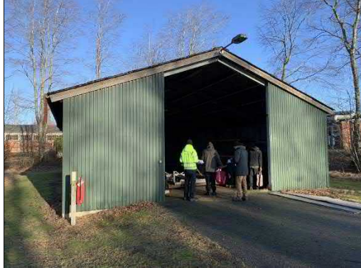
Foto 3: Bygningens sydlige facade.
