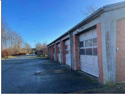
Foto 2: Nordlige facade af bygning 3 med vaskepladser (kilde 10126-0003) med fald til nedløbsriste.
