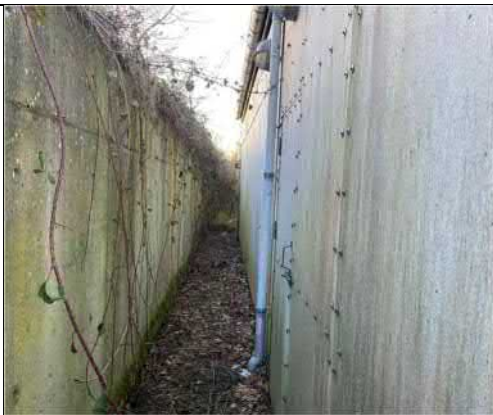
Foto 10: Støttemur mod øst, udfor bygning med tunnelovne.
