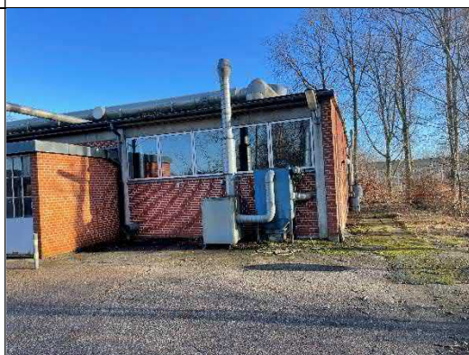
Foto 9: Sydvestligt hjørne af tilbygning, hvor der i 2004 var et udendørs oplag af fortynder og fortynderaffald.
