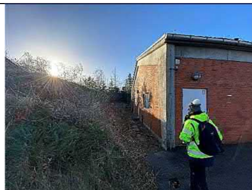
Foto 2: Østlige gavl – mod jordvold og bygning 9. Foto set mod syd.
