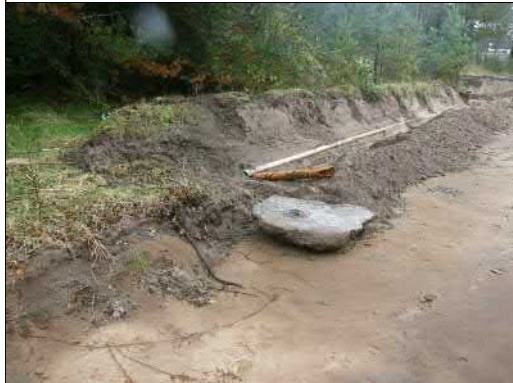
Foto 5: Udgravningens nordlige gravefront - rørføringer fra afløbsriste ført til olieudskiller.
