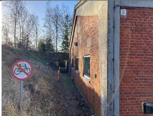
Foto 1: Østlige gavl med jordvold. Foto set mod syd.
