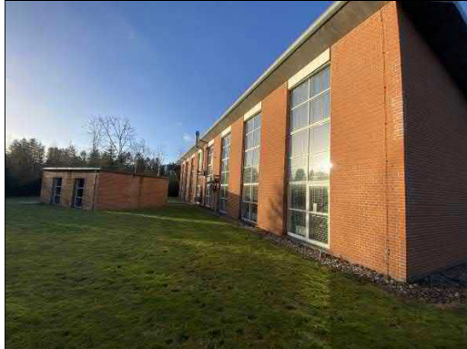
Foto 3: Bygningens østlige facade.
