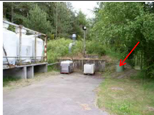
Foto 1: Spildevandstanke ved bygning 69. Den grønne tank til højre har været brugt til natronlud.
