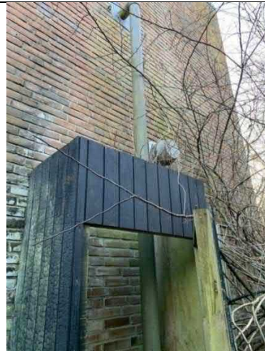
Foto 2: Afkast mv. ved bygningens vestlige facade.
