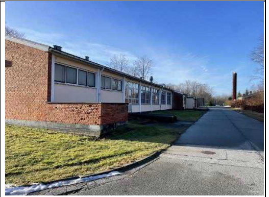
Foto 6: Bygningens nordlige facade, foto taget mod vest.
