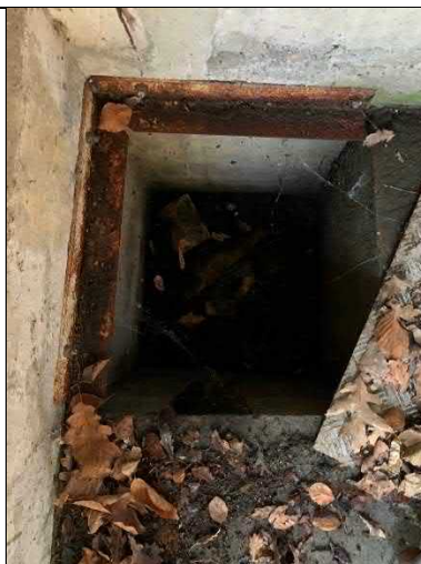
Foto 7: Pumpegrube i det sydvestlige hjørne.
