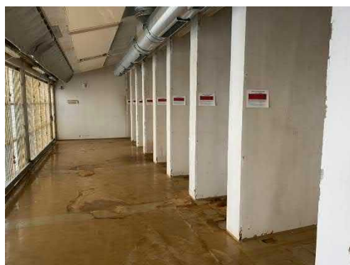
Foto 7: Gitter- og køleceller ved den nordlige facade.
