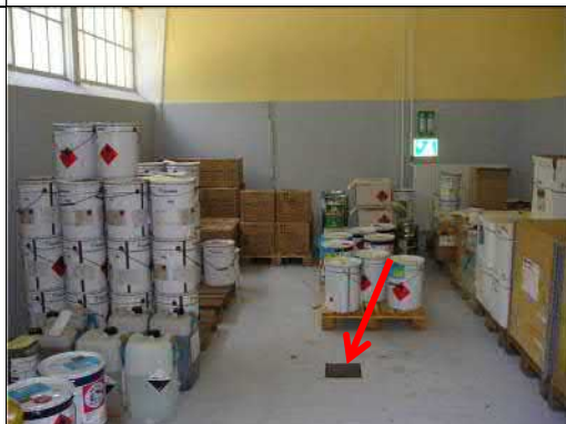
Foto 1: Bygning 31, oplag af maling, lak og fortynder. Pumpeump i gulvet ses ved rød pil.
