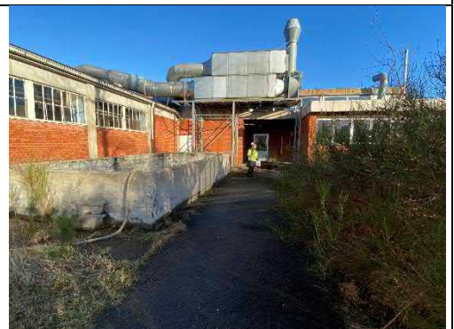
Foto 8: Slamtank er fjernet fra tankgård, som er tom og rengjort. Der er boret hul i tankgård, så der ikke ophobes regnvand.
