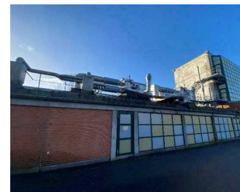
Foto 10: Bygning 6' nordlige facade med asfaltbelægning. Foto set mod sydvest
