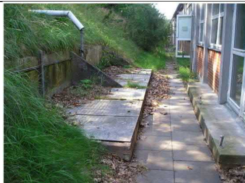
Foto 1: Bundfældningsbassin (6a) syd for bygning 6. Foto set mod vest (2004).
