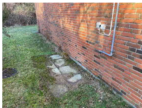
Foto 4: Område ved den sydlige langside, hvor der evt. har været placeret en tank.
