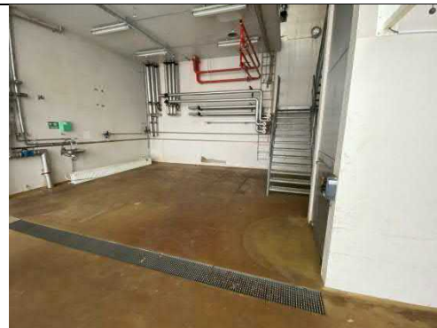
Foto 6: Støbetårnet i midten af bygningen (stueplan).
