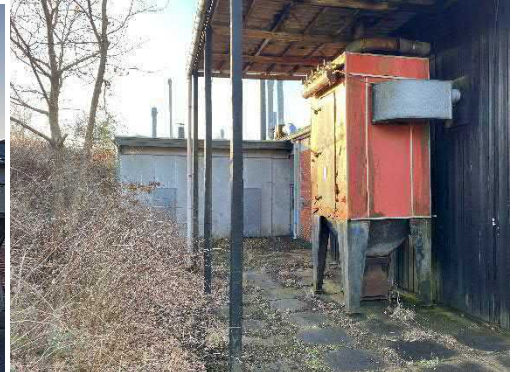
Foto 5: Udsug/filter ved den nordlige gavl (forventeligt fra slyngrenser).
