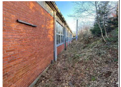
Foto 4: Sydlig facade – ud mod jordvold og med udsug der kan anes centralt i foto. Foto set mod øst.
