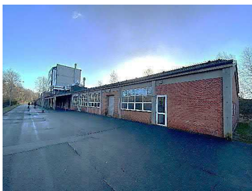
Foto 3: Bygning 6' nordlige facade med asfaltbelægning. Foto set mod sydøst.
