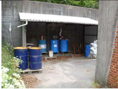
Foto 1: Oplagsskur ved bygning 5 (bygning 5a) med malingsrester og opløsningsmidler.
