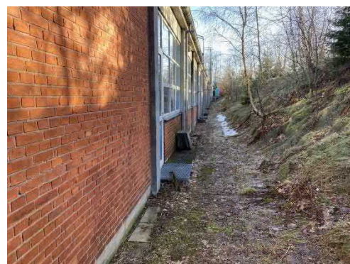
Foto 4: Bygning 6's sydlige facade og jordvold. Foto set mod øst. Afkast ses længst mod øst bagerst i billedet (overvejende befæstet areal).
