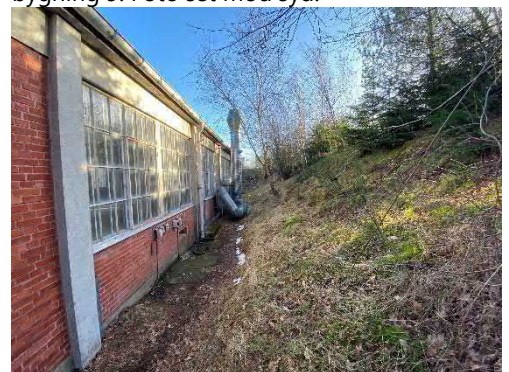
Foto 4: Sydlig facade med udsug – ud mod jordvold. Foto set mod øst.
