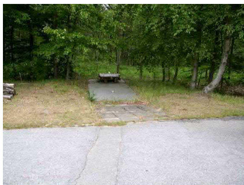
Foto 1: Dæksler for 4.000 l tank i betonkar.
