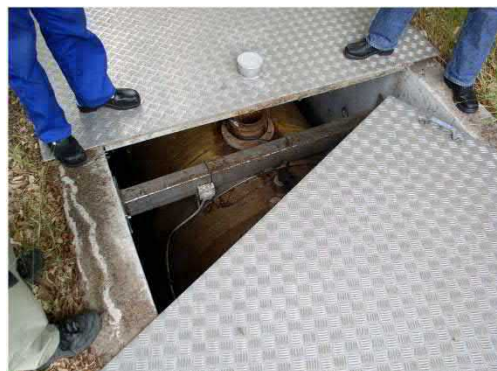
Foto 2: Her ses selve tanken nede i betonkarret nord for bygningen.
